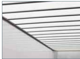
Toit translucide composé d'arceaux transversaux en aluminium et couvert de plaques de polyester translucides.
