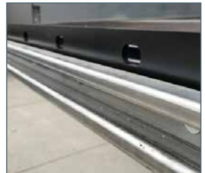
Rail de guidage inférieur Rail solide en Nirosta vissé sur le cadre extérieur
